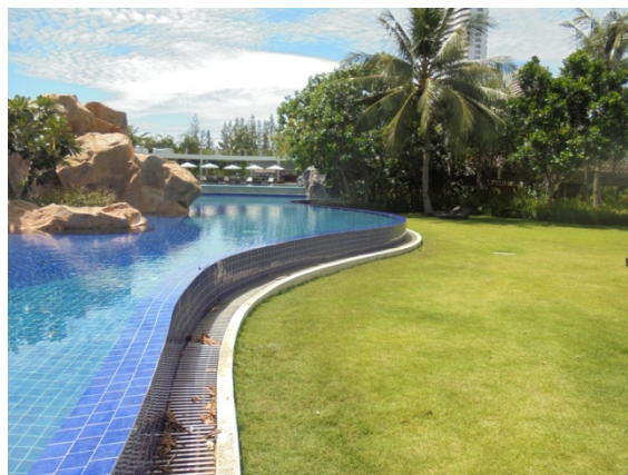
ภาพที่ 4-43 รางระบายน้ำล้นรอบสระว่ายน้ำ
