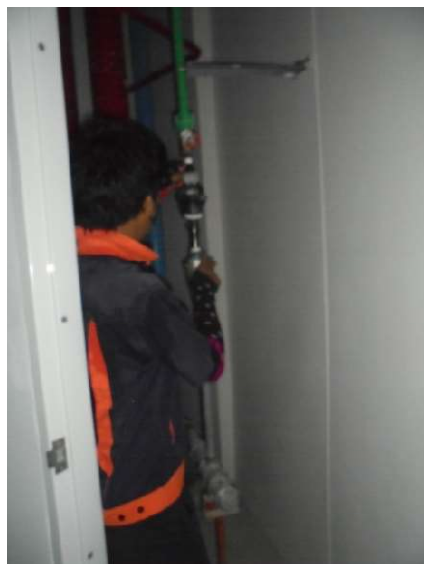
ภาพที่ 4-16 ตรวจสอบรอบต่อท่อประปา ไม่มีการรั่วซึม
