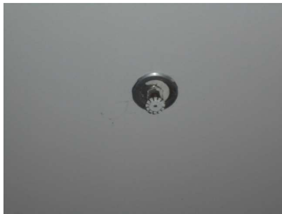
ภาพที่ 4-28 หัวกระจายน้ำดับเพลิง (Sprinkler)
