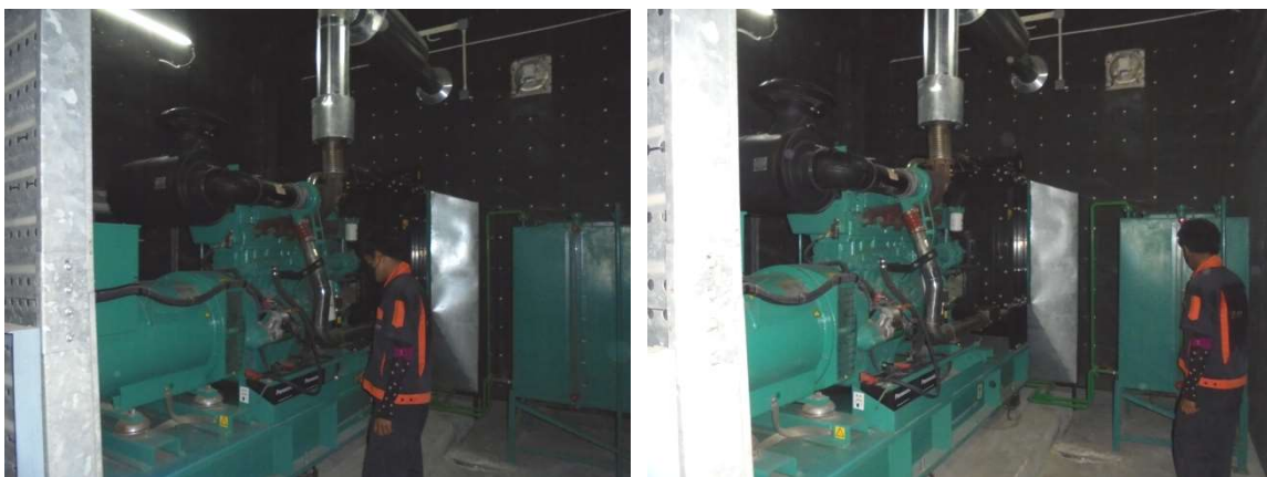
ภาพที่ 4-18 ห้องกำเนิดไฟฟ้าสำรองฉุกเฉินและตรวจสอบทุกสัปดาห์
